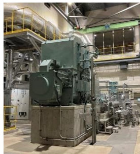
※発電機・蒸気タービン※
