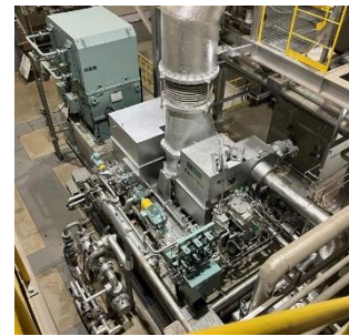
※発電機・蒸気タービン※
